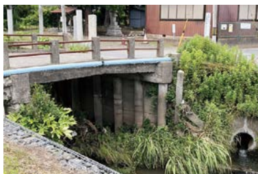
新川にかかる鹿島橋と雨水管吐口部
