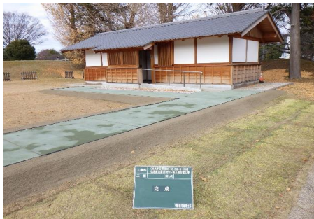
①トイレアプローチ園路の整備
