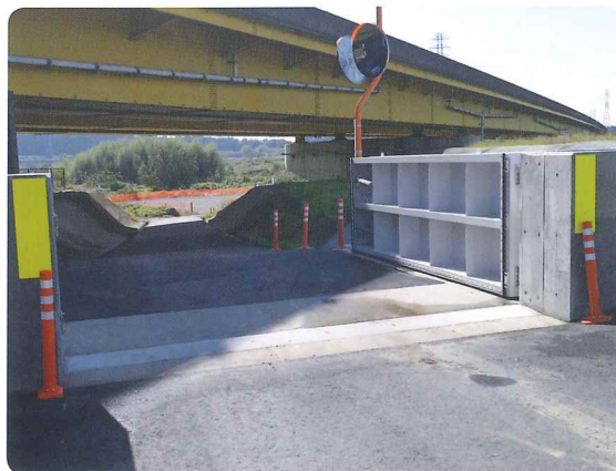
◀常磐高速道路下の浸水防止施設の擁壁と陸閘
