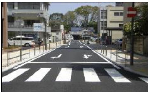
市道200号線整備事業（歩車道整備・電線地中化等）
